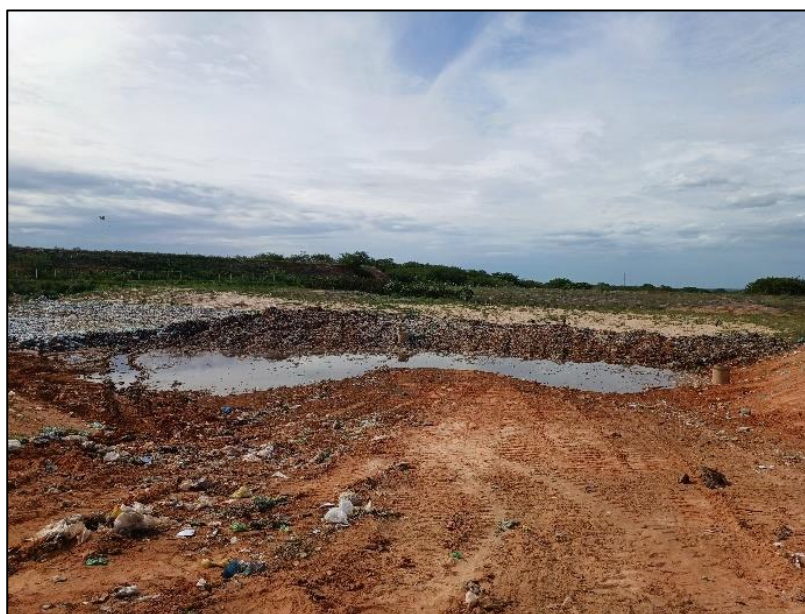
Figura 63 – Poça de água de chuva acumulada sobre a massa de resíduos
