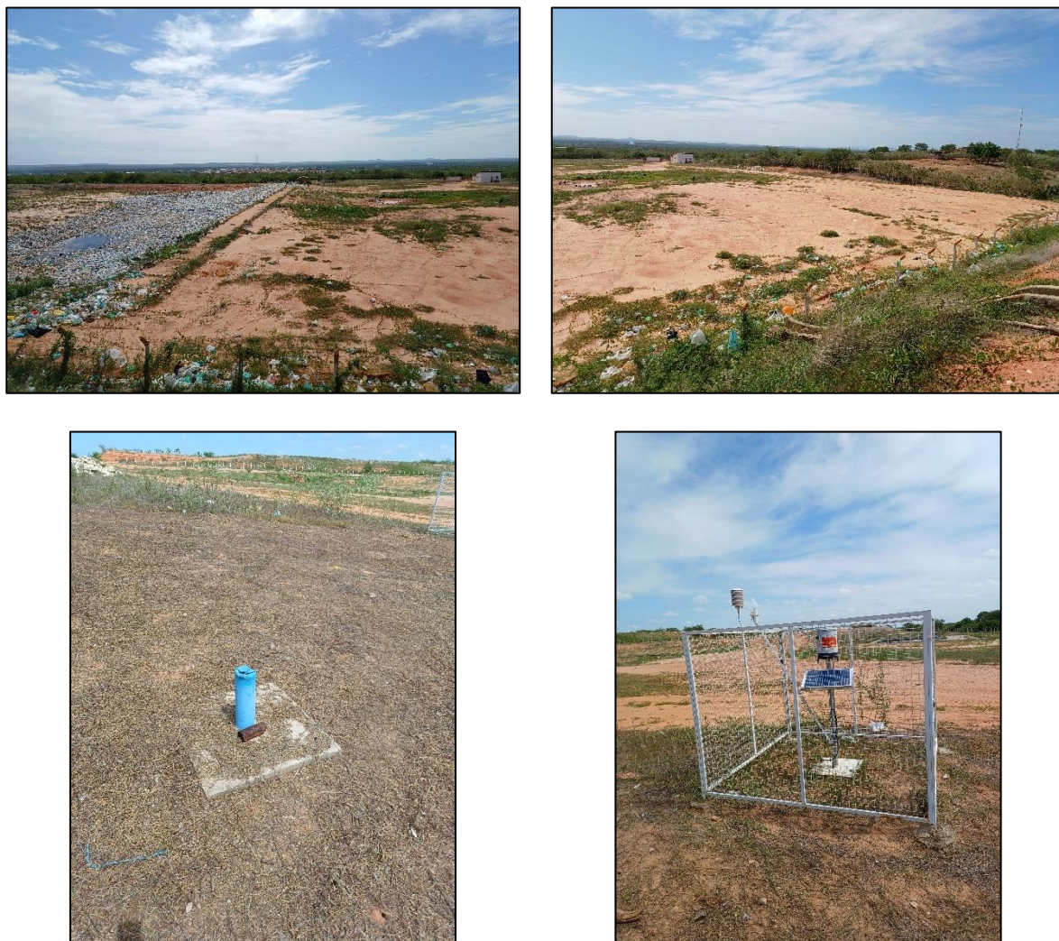
Figura 58 – Aspectos gerais do aterro sanitário de Upanema/RN
