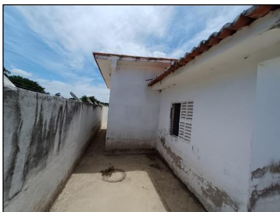
Figura 35 – Manchas de umidade na edificação e descascamento de pintura
