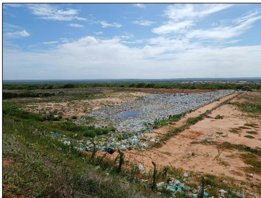
Figura 59 – Utilização desordenada do aterro
