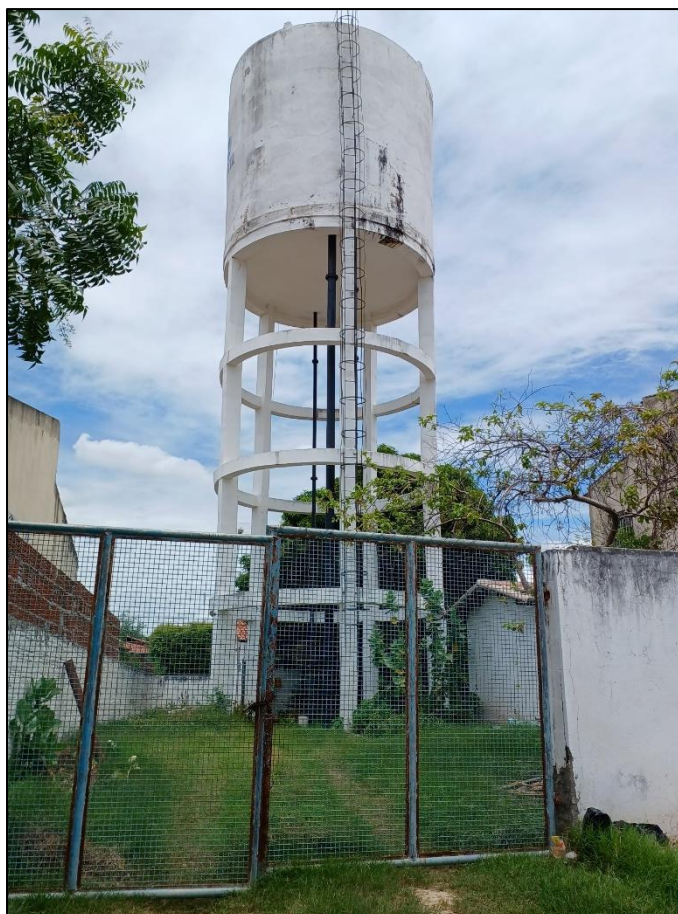
Figura 12 – Reservatório de água
