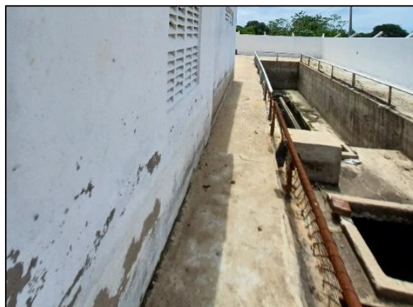
Figura 35 – Manchas de umidade na edificação e descascamento de pintura
