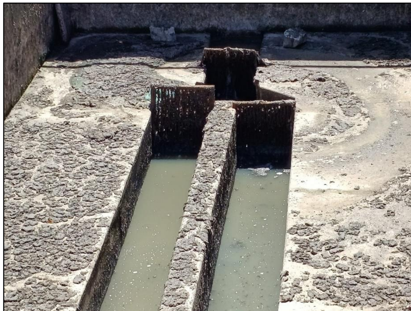
Figura 32 – Grade fina mal posicionada e com lodo acumulado
