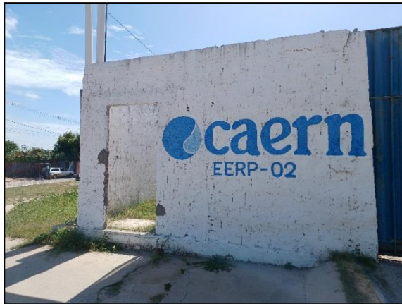
Figura 14 – Booster 2 (Booster próximo ao Estádio)
