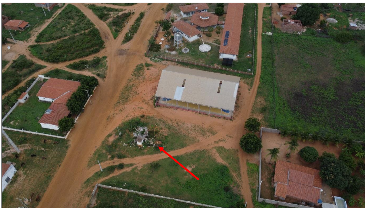
Figura 20 – Reservatório elevado demolido da comunidade de Palheiros III
