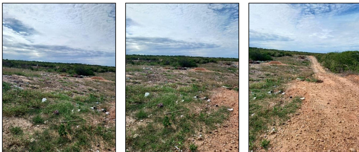
Figura 54 – Disposição inadequada de resíduos comuns na área do bota-fora
