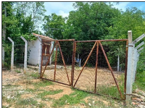
Figura 9 – Área do Poço 2
