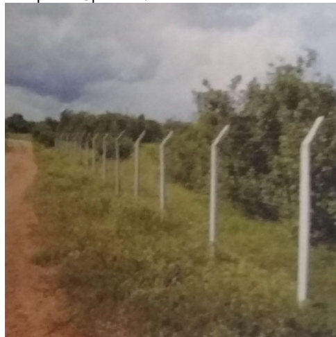
Foto 02 – Área cerrada em todo entorno.
